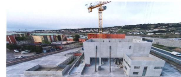
Chantier de Nice. Durée des travaux 12 mois. Coût des travaux 3M. Mur grande hauteur, en gris : 14m haut ; en rouge : 17.35m haut
