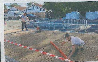
Travaux sur le parking devant la Forestière. s.s.
