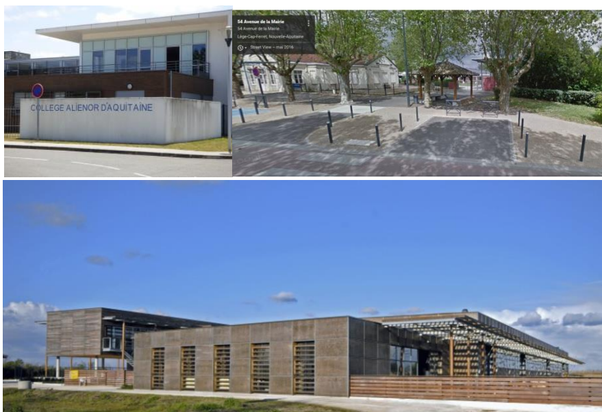
Collège Aliénor d'Aquitaine à Salles ; Collège Jean Coteau à Lège-Cap Ferret (haut) Lycée de la mer et de l'espace à Gujan Mestras (en bas)
